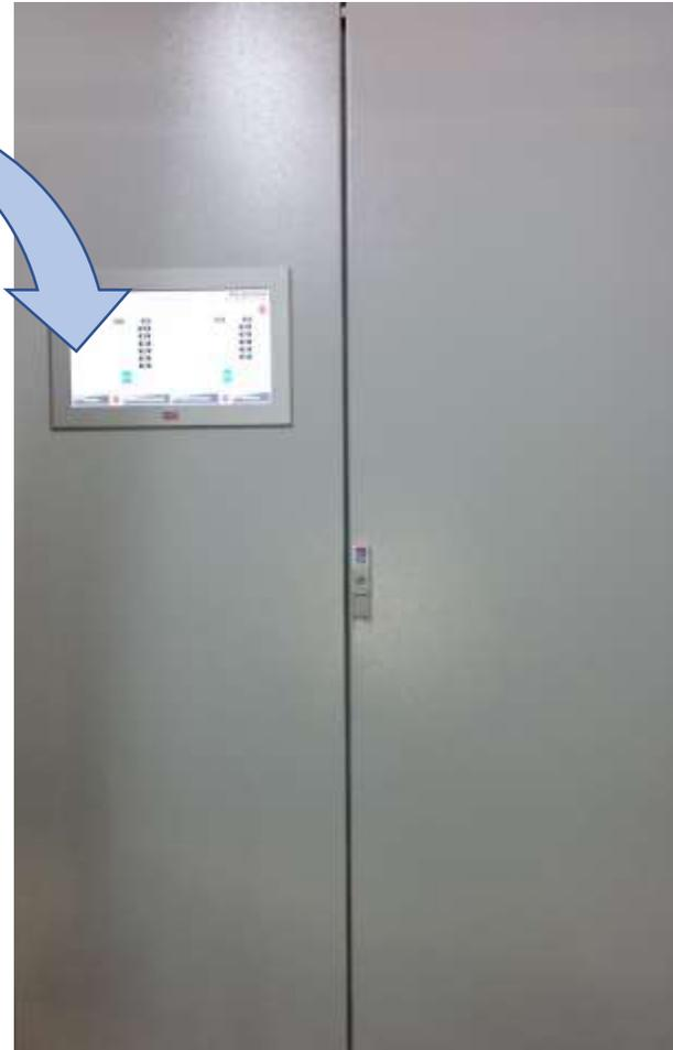
Elektromechnik von 1978 durch SPS-Steuerung mit intuitiver Benutzeroberfläche ersetzt
